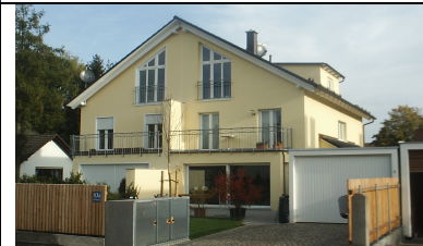
Bau DHH München / Heilwigstr. 2004
