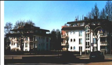
PE / Bau WA HH- Hagenbeckallee, 98
